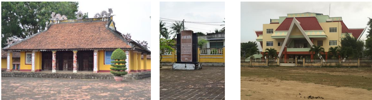
Hình 13: Hiện trạng công trình di tích An Khê Trường
