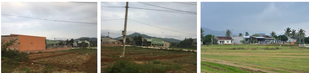
Hình 15: Hiện trạng công trình nhà dân trong khu vực nghiên cứu
